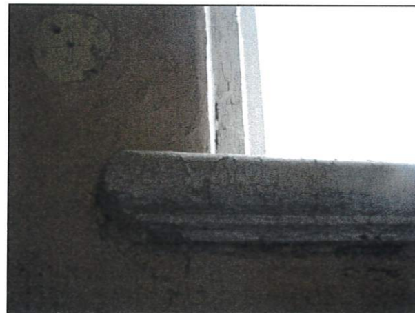
RESTAUROJAMŲ TAIKANT NAUJAS TECHNOLOGIJAS LANGŲ PALANGĖS VAIZDAS. PALANGĖ - PROFILIUOTA
