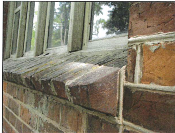
RESTAUROJAMA LANGO PALANGĖ IŠ PLYTŲ
